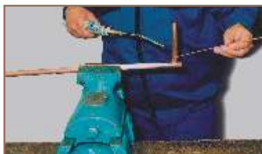
8. Kötés melegítése, forrasztóanyag megolvasztása
