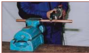
7. Présprofa nyitása, merőleges ráhelyezése a présidomra és a préselés elindítása. A présprofáknak teljesen össze kell csukódnuk.
