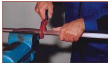
1./b Csődarabolás Munkaeszköz: görgős csővágó
