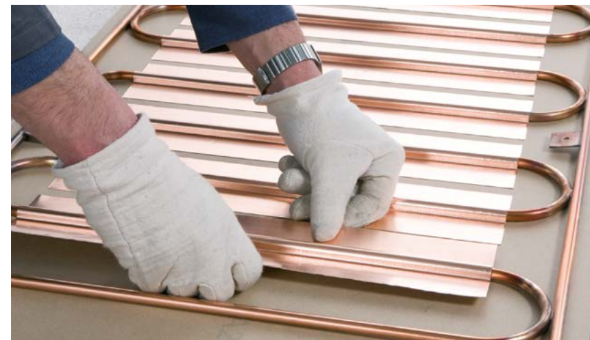
Gipszkartonra szerelt előregyártott réz tekercsek
